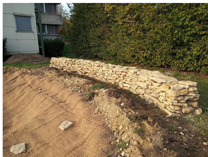
Un muret en pierres digne des plus grands architectes !
