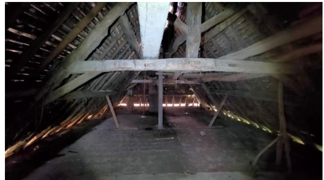
Grenier d'une maison abandonnée à Corbelin, favorable aux chauves-souris
